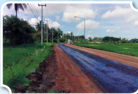
โครงการปรับปรุงผิวจราจรถนนลาดยางแอสฟัลต์ติกคอนกรีต แบบPAVEMENT INPLACE RECYCLING ถนนเหมืองไทร - บ้านแขก บริเวณหมู่ 3,1 ตำบลท่าแร่ งบประมาณ 4,896,000 บาท
